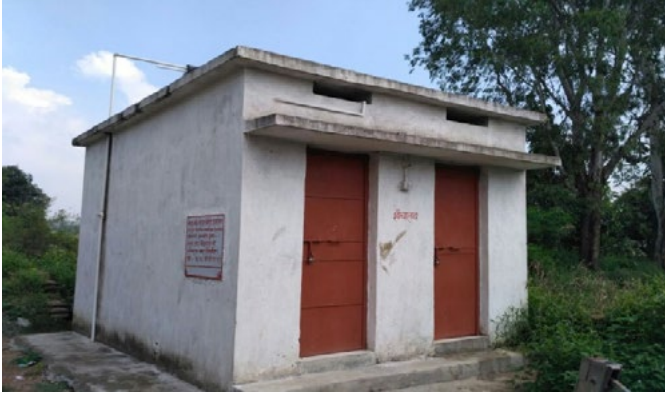
सीएसआर के तहत शौचालय का निर्माण
